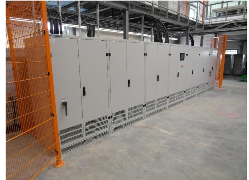
AC-Versorgung, 1 MVA (2 Einheiten à 500 kVA)
