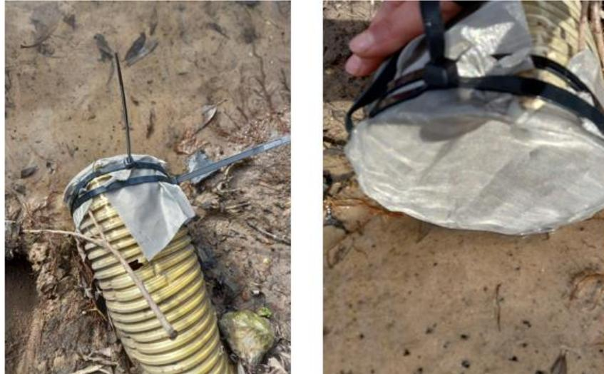
Abbildung 19: Ansicht Einleitungsstelle in den Riedenbach mit Metallgewebe als Siebeinsatz und Kabelbinde zur Fixierung.
