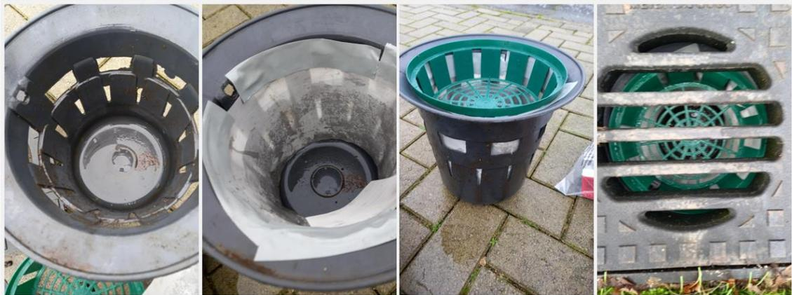
Abbildung 18: Aufbau eines feinen Siebes. Grober ursprünglicher Siebeinsatz (links) mit Erweiterung eines feineren Siebeinsatzes. Ansicht kombiniertes Sieb im Gitterschacht (rechts). Siebeinsätze DIN 1236, Hof-sinkkasten.
