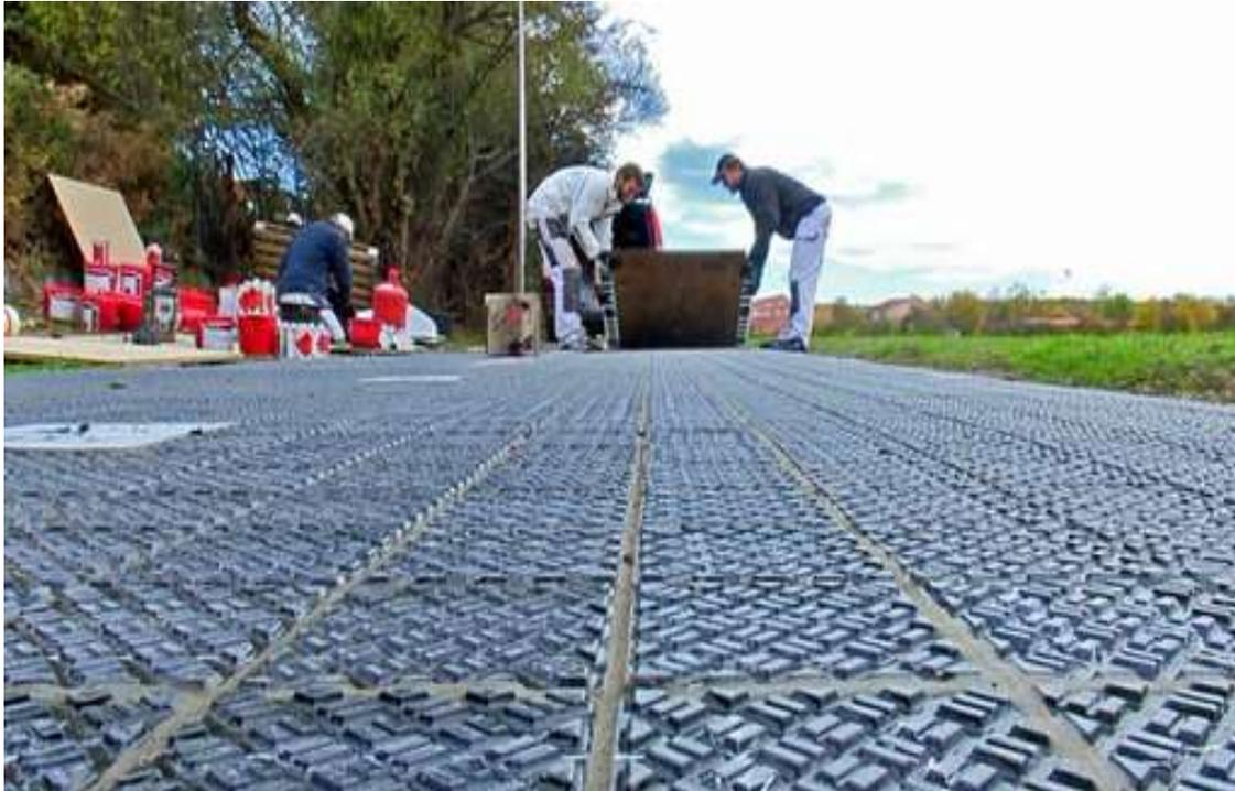
Solarradweg 200 m<sup>2</sup> Fläche, 12 MWh/a Strom,
