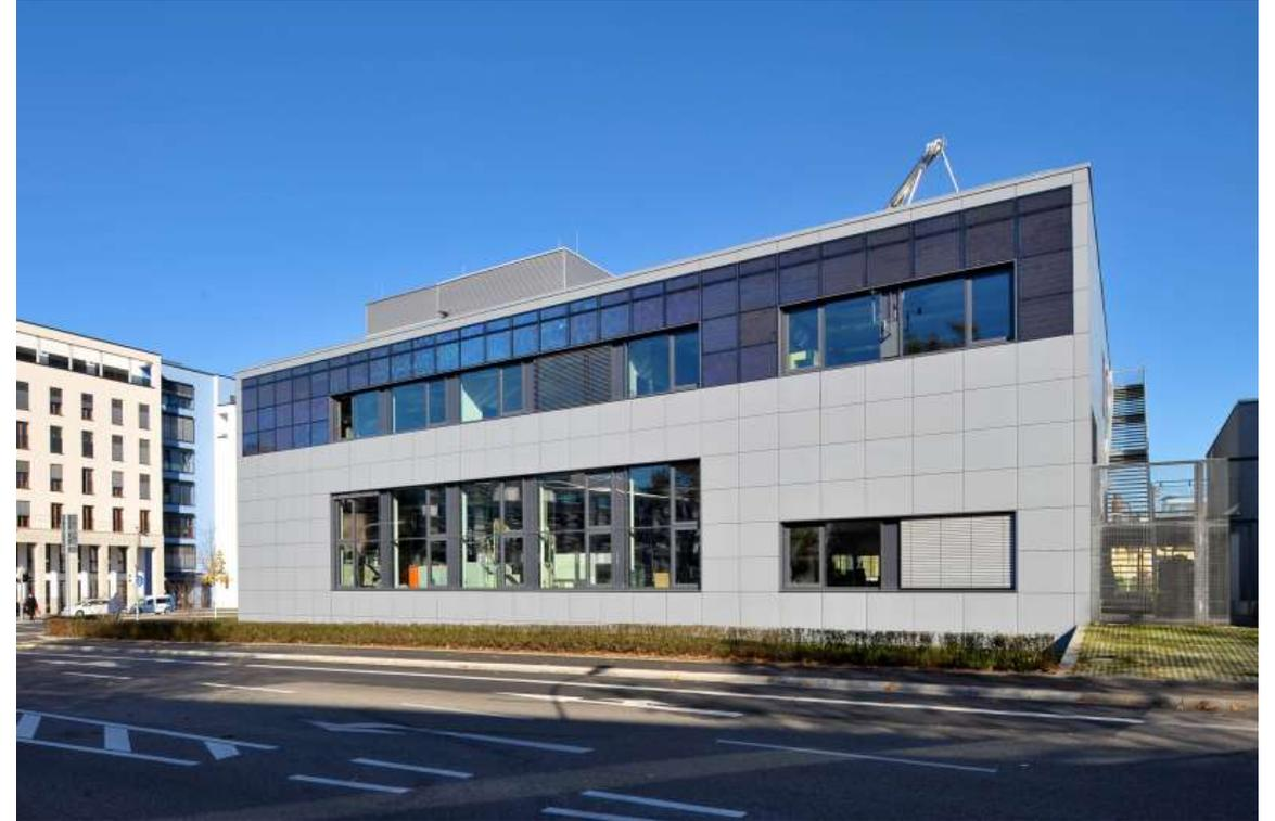
Bauwerkintegrierte PV (ISE-Labor)
