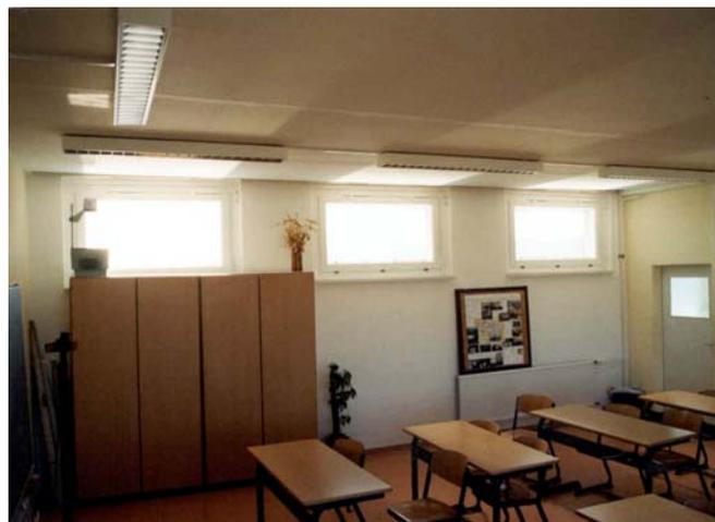
Bild 6 Ansicht der Südfenster der Normalklassenräume mit lichtumlenkenden Lamellen
