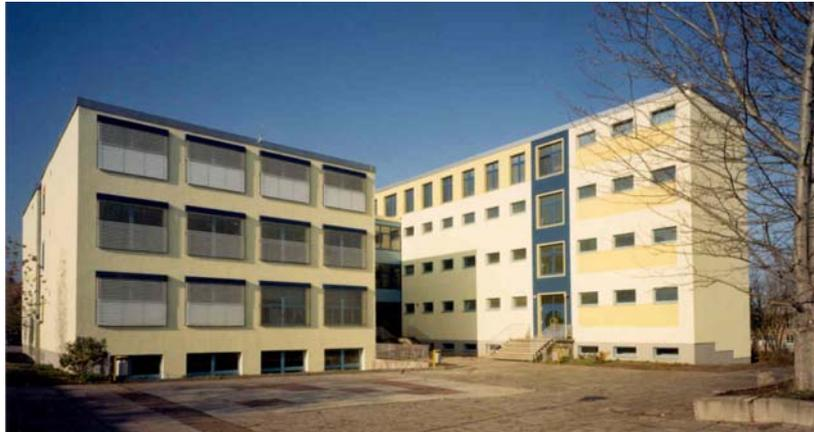
Bild 7 Ostansicht des Gebäudes; außenliegende Lamellenjalousien mit unterschiedlichen Verschattungseinstellungen
