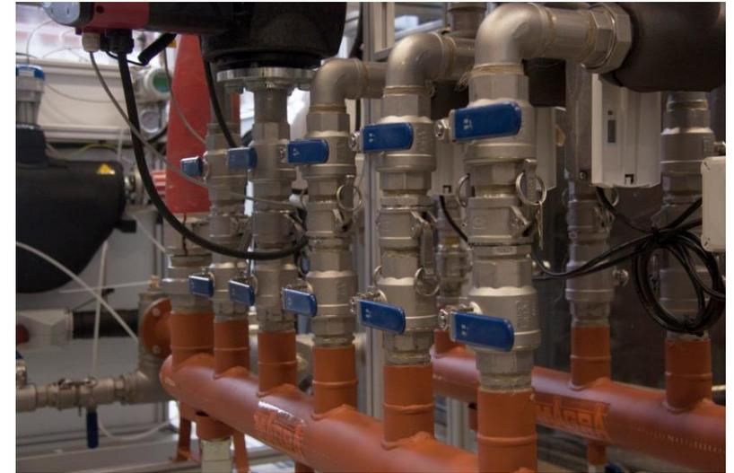
Verteiler und Sammler der Mehrquellenhydraulik im Teststandaufbau
