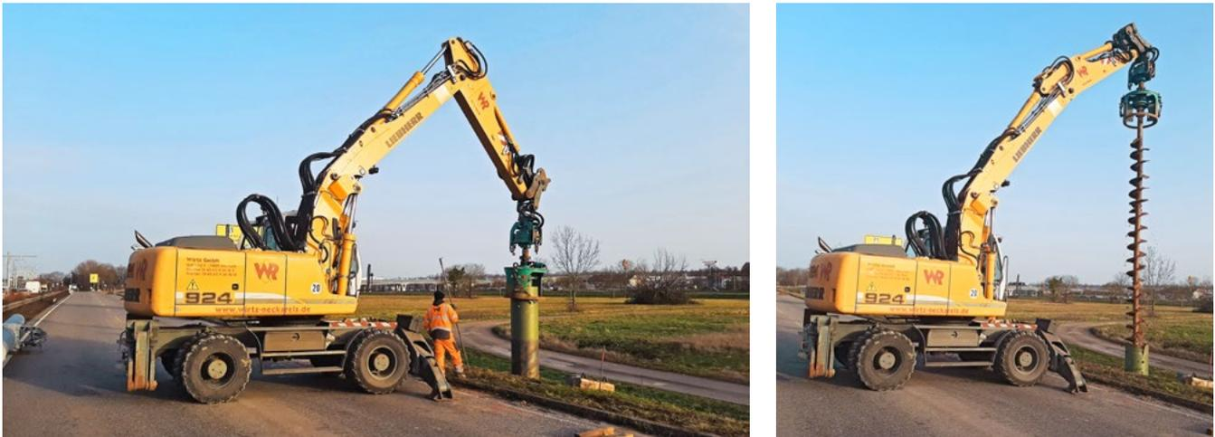
Abbildung 2: Einbringen der Fundamentrohre im Dreh-Bohrverfahren (Quelle: „eWayBW“)
