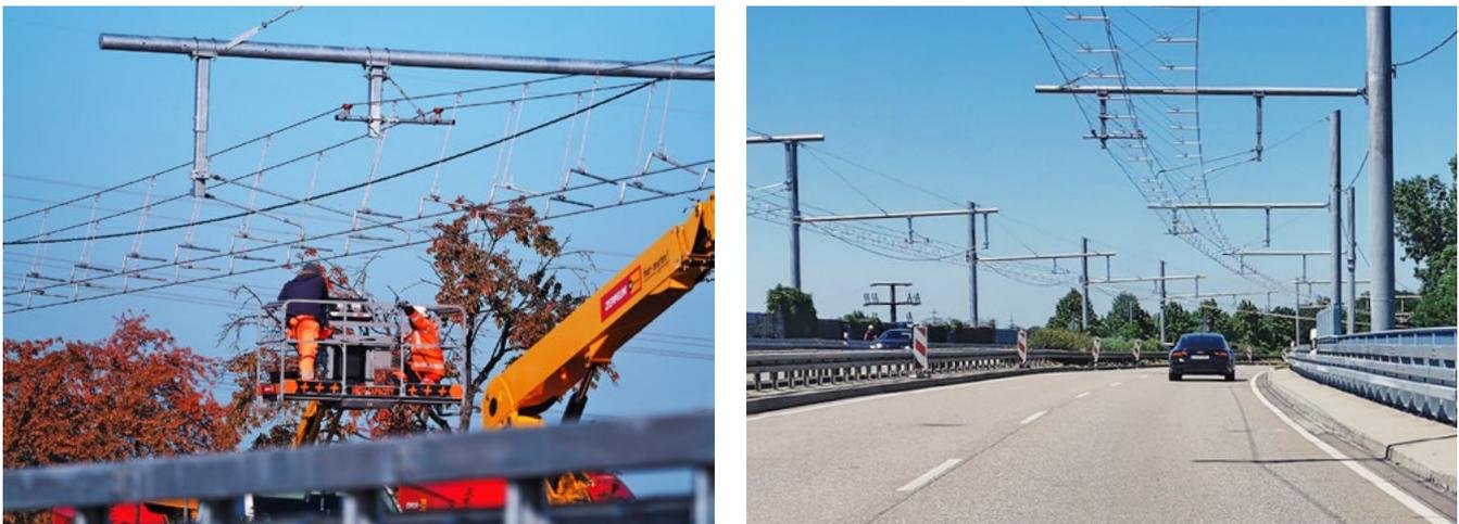
Abbildung 3: Montage der Hänger und windschiefe Oberleitung im Kurvenbereich (Quelle: „eWayBW“)
