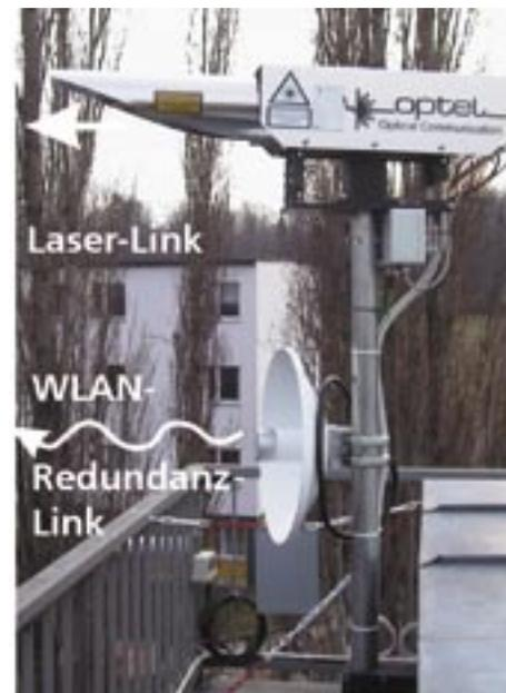
Abb. 4: Laser-Link mit Anbindungsantenne vom WLAN-Redundanzsystem.
