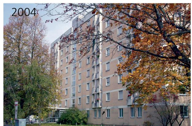
**Bild 1:** Ansicht der Westfassade vom Objekt 16 in München, 4 Jahre (1989) und 19 Jahre (2004) nach dem Aufbringen des WDV-Systems ohne zwischenzeitliche Renovierung. Das Dämmsystem blieb funktionsfähig ohne technische Mängel.
