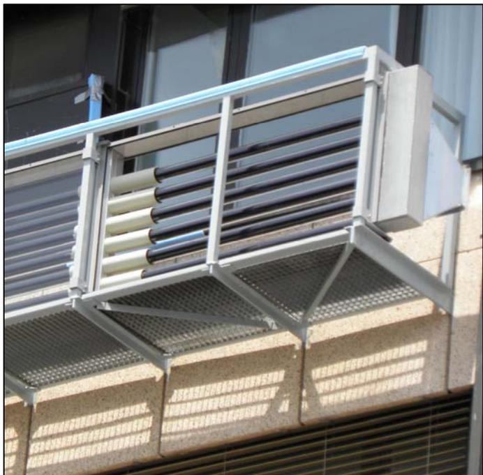
Abbildung 1: Vakuumröhren-Luftkollektor für Fassaden
