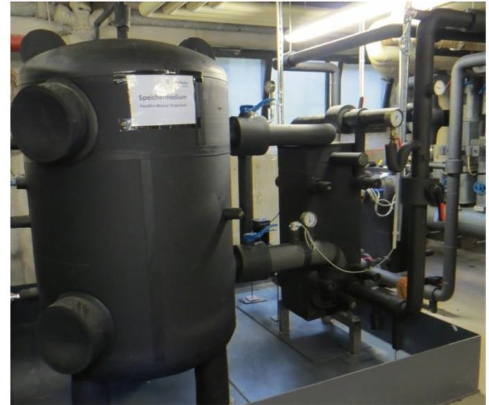
Ein vergleichbarer Kaltwasserspeicher hat eine Speicherkapazität von ca. 9 kWh (bei  $\Delta T = 5 \text{ K}$ )!
