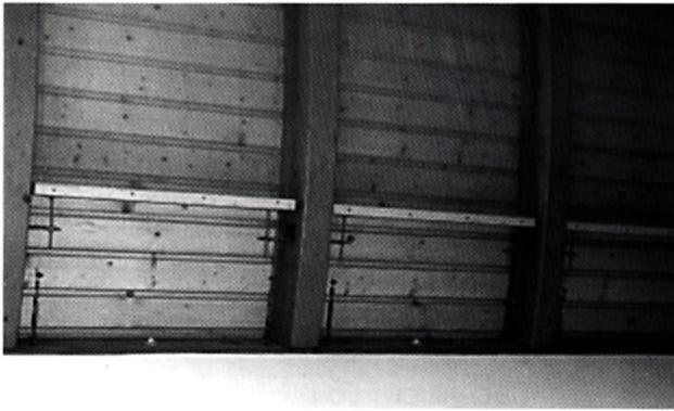
Bild 3: Foto der Folienabsorber zwischen den Sparren der Dachkonstruktion.
