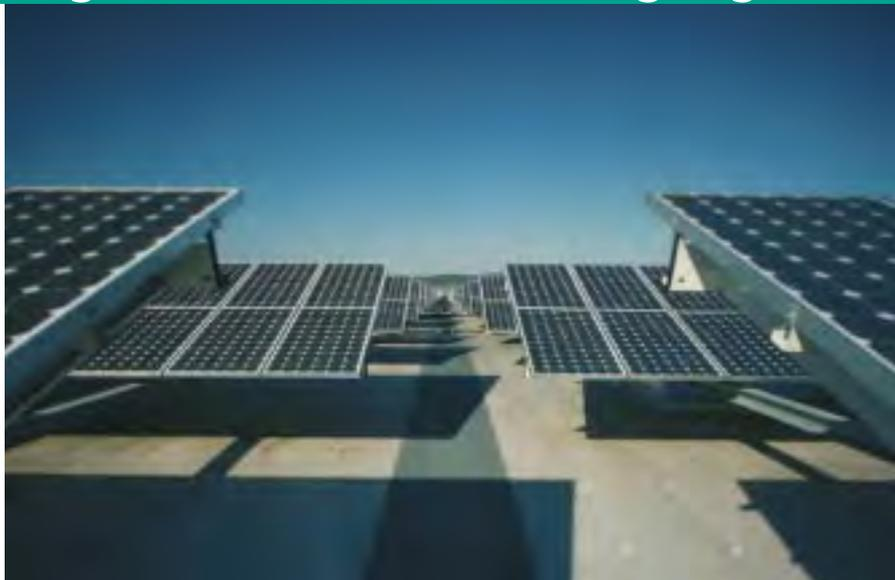
Eines der weltweit größten Solarkraftwerke ist auf dem Dach des BMW-Konsolidierungslagers in Dingolfing an der Isar realisiert. Der Solargenerator besteht aus mehr als 18 000 Modulen und hat eine Gesamtleistung von 3,3 Megawatt. Das Fraunhofer ISE führte umfangreiche Messungen zur Sicherstellung der Leistung und Qualität der Anlage durch.
