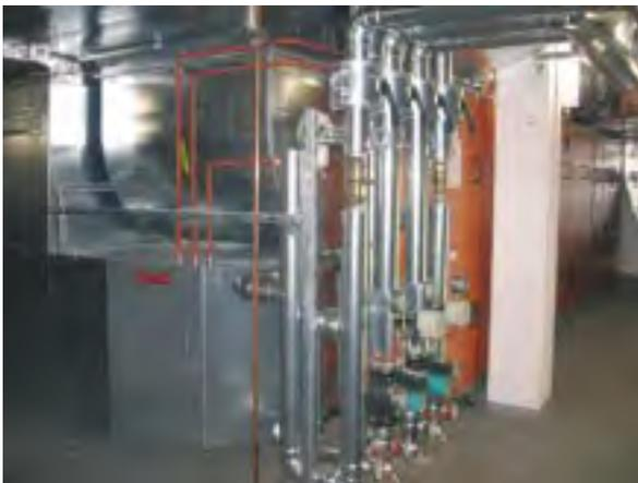
Abb. 1: Projekt Liquisorp: Fertig installierte Anlage im Universitätsklinikum Freiburg. Das Bild zeigt den kompakten, rot-orangefarbenen Kubus des Klimageräts. Im Vordergrund sind die Heizkreise für die Soleerwärmung im Regenerator (Sommerbetrieb) und für das Zuluft-Heizregister (Winterbetrieb) zu erkennen.
