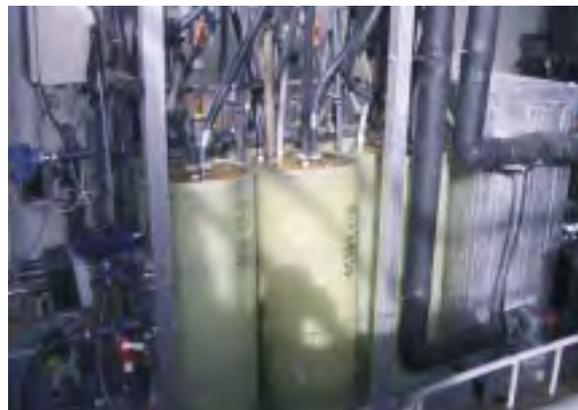
Abb. 2: Bei der Zweikreisanlage auf Gran Canaria sind fünf Entsalzungsmodule in Betrieb. Das Kollektorfeld hat eine Größe von 90 m<sup>2</sup> und besteht aus Flachkollektoren mit einer doppelten, antireflexbeschichteten Glasabdeckung. Hierdurch kann auch bei hohen Betriebstemperaturen von 80–100 °C noch ein guter Wirkungsgrad von 50–60% erreicht werden. Der thermische Speicher hat ein Volumen von 4 m<sup>3</sup>.
