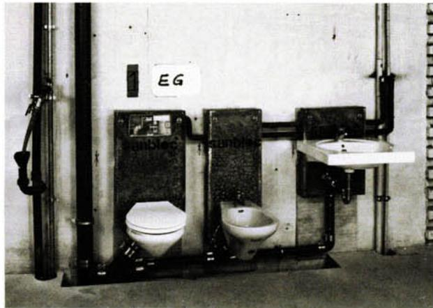
**Bild 3:** Vorgefertigte Sanitär-Bausteine an der Installationswand im EG des Installations-Prüfstandes
