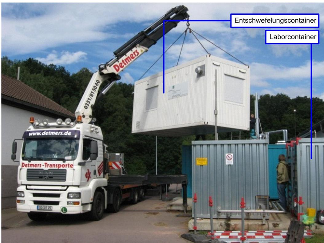
Abbildung A.15: Biogas v1.0: Laborcontainer bei der Aufstellung auf der Kläranlage Roßwein
