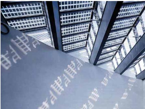
Abb. 6: Sheddach im Atrium des Fraunhofer ISE mit integrierter Photovoltaik.
