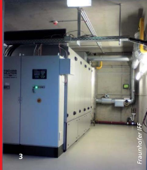
Die Wirtschaftlichkeitsbetrachtung bestätigte die Anlagengröße und -fahrweise: wärmegeführt und stromgedeckelt. Das BHKW wird somit in erster Linie in Abhängigkeit des Wärmebedarfs betrieben. Das geschieht nur dann, wenn die erzeugte Strommenge bei der NTT selbst verbraucht werden kann. Eine Ausspeisung der Elektroenergie ins öffentliche Netz wird zwar vorgesehen, soll aus derzeitigen wirtschaftlichen Gründen jedoch nicht praktiziert werden.
