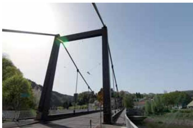
Abb. 4: Saar-Brücke in Mettlach mit einbetonierten Verankerungen der Spannseile
