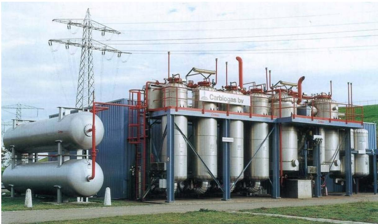
Abbildung 4-10: VPSA-Anlage zur Biogasaufbereitung der Fa. Cirmac (Quelle Cirmac, NL)
