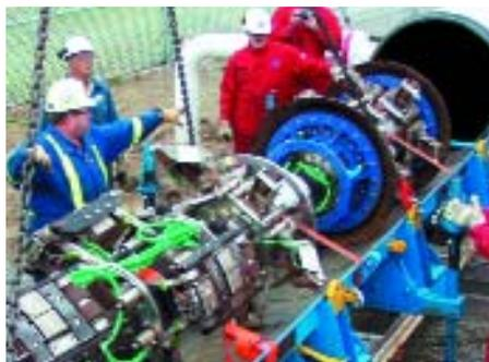
EMAT-Molch beim Einschleusen in die Gaspipeline in Maticé, Kanada
