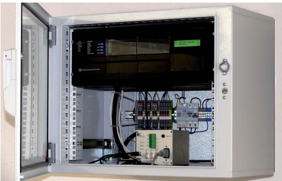
Bild 2: Blick in den Schaltschrank mit der darin installierten PMU zur Überwachung der Netzparameter am Mittelspannungsanschluss des VDTC. Foto: Thoralf Winkler
