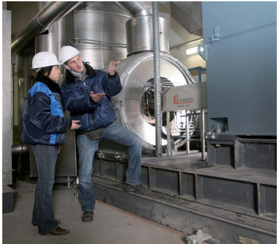
Bild 1: ORC-Turbine im Biomasse-Heizkraftwerk Robeta Milnersdorf. Foto: Dirk Mahler
