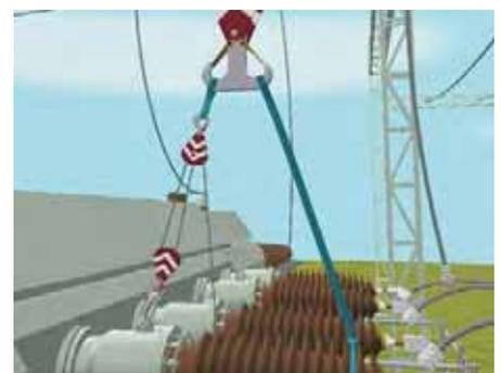
Bild 2: VR-Darstellungen von Demontearbeiten an Durchführungen und Diffusoren.
