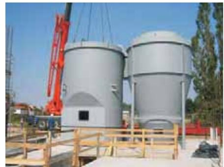
Bild 2: Stahlbaumontage der Feuerungsanlage. Foto: Matthias Gohla
