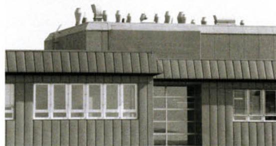
Bild 1: Typische Anordnung von Lüftungseinrichtungen auf Industriedächern
