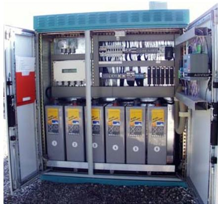
Abb. 5: Schaltschrank zur Aufnahme von Energiespeicher und Steuerelektronik.
