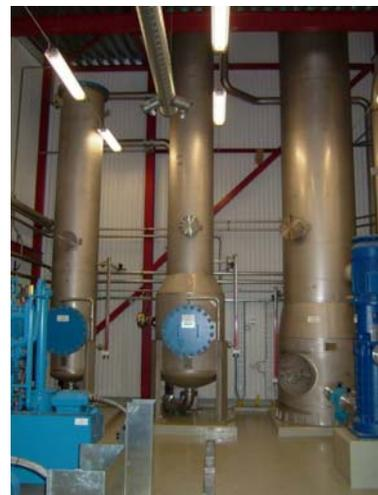
Abbildung 4-5: Druckwasserwäsche der Fa. YIT in Norrköpping (links) und Västerås (rechts) (Quelle Ros Roca)
