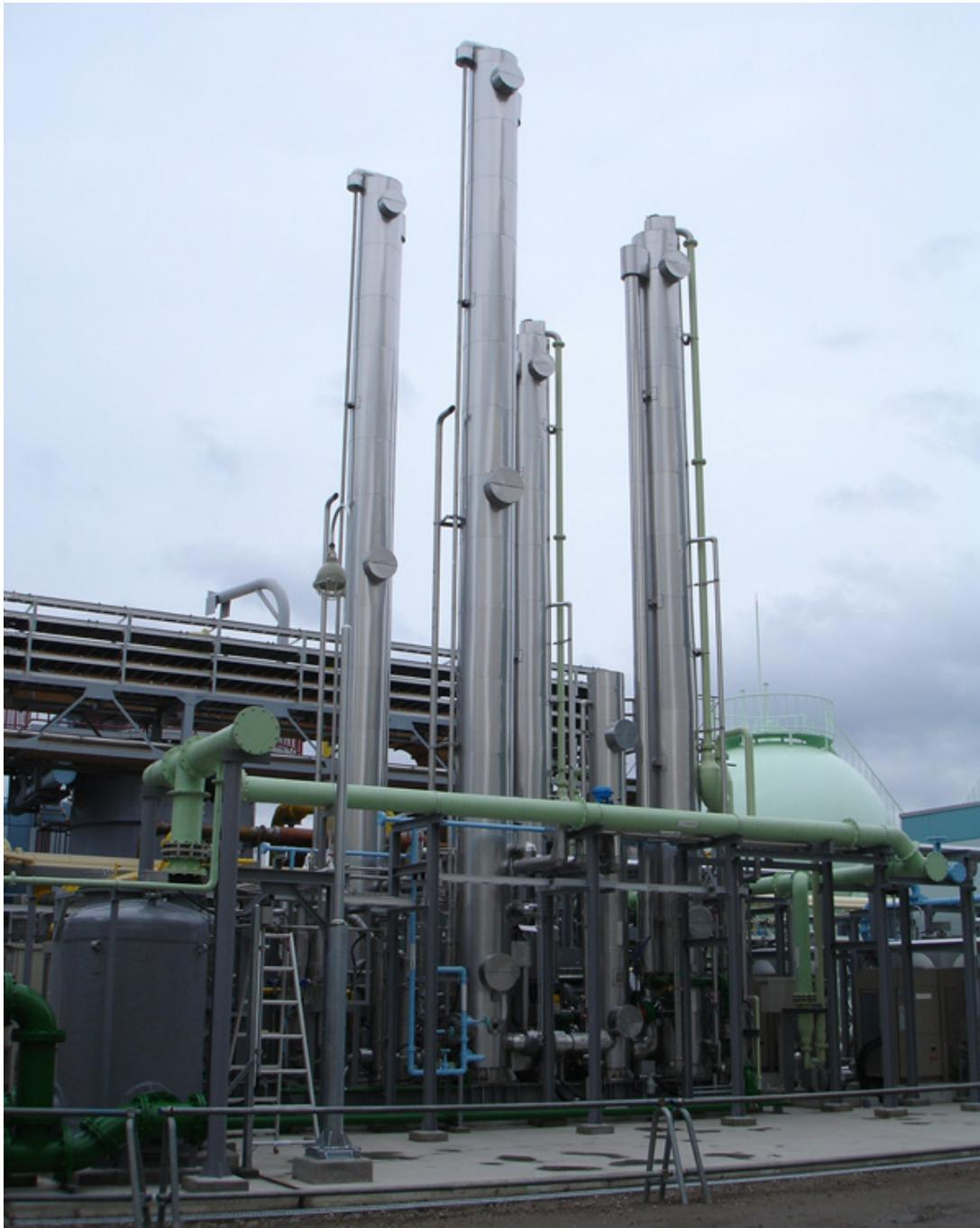
Abbildung 4-4: Flotech-Druckwasserwäsche CSFR-225 in Kobe, Japan (Quelle: Flotech)
