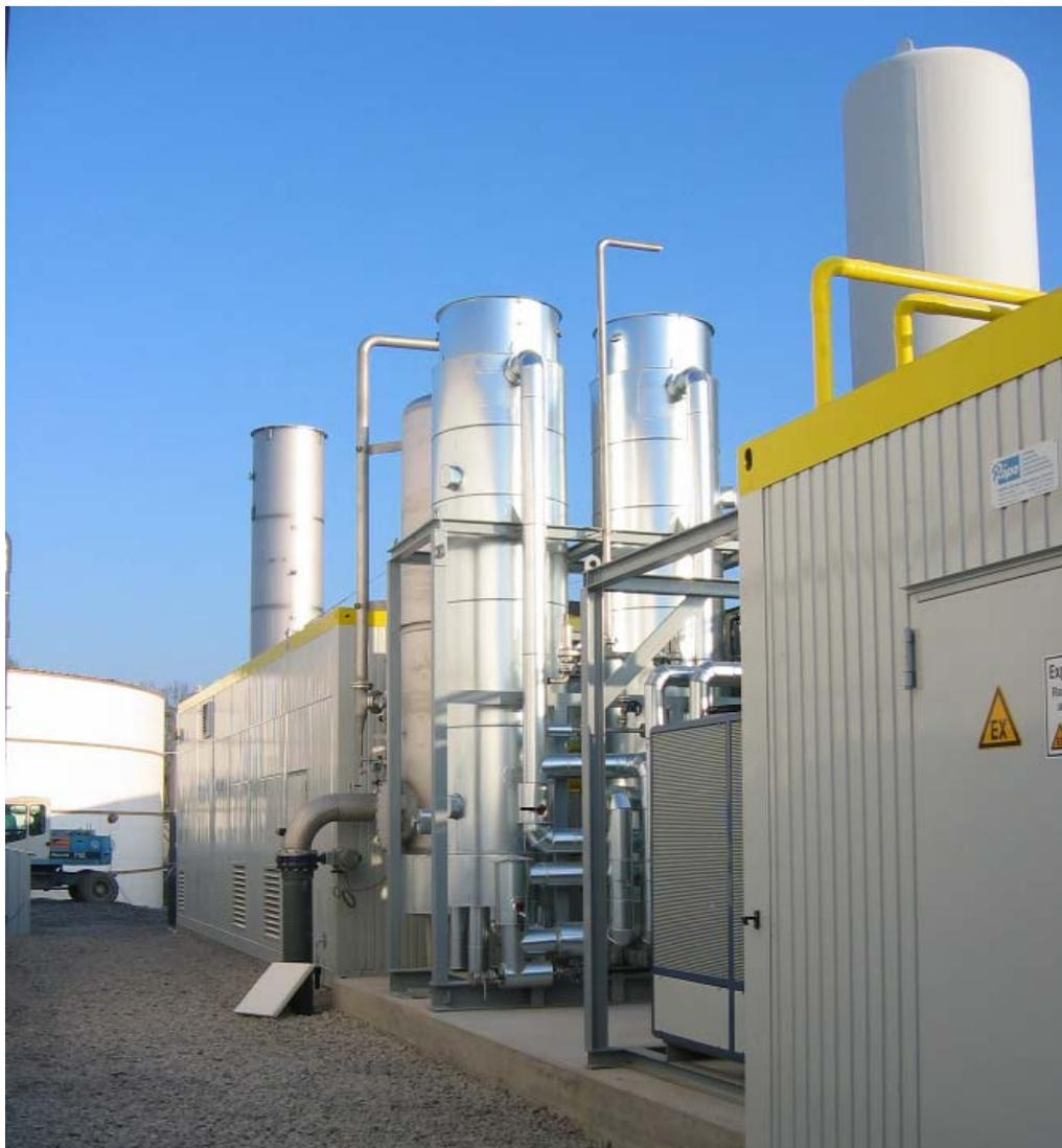
Abbildung 4-7: PSA-Anlage der Fa. CarboTech in Mühlacker (Quelle: CarboTech 2008)
